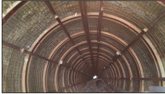
Figura 10: Ingreso al interior del pique existente en NK, con agua en su interior.
